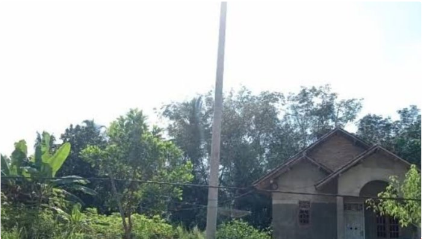
Tiang Listrik di Tanah tak Bertuan
