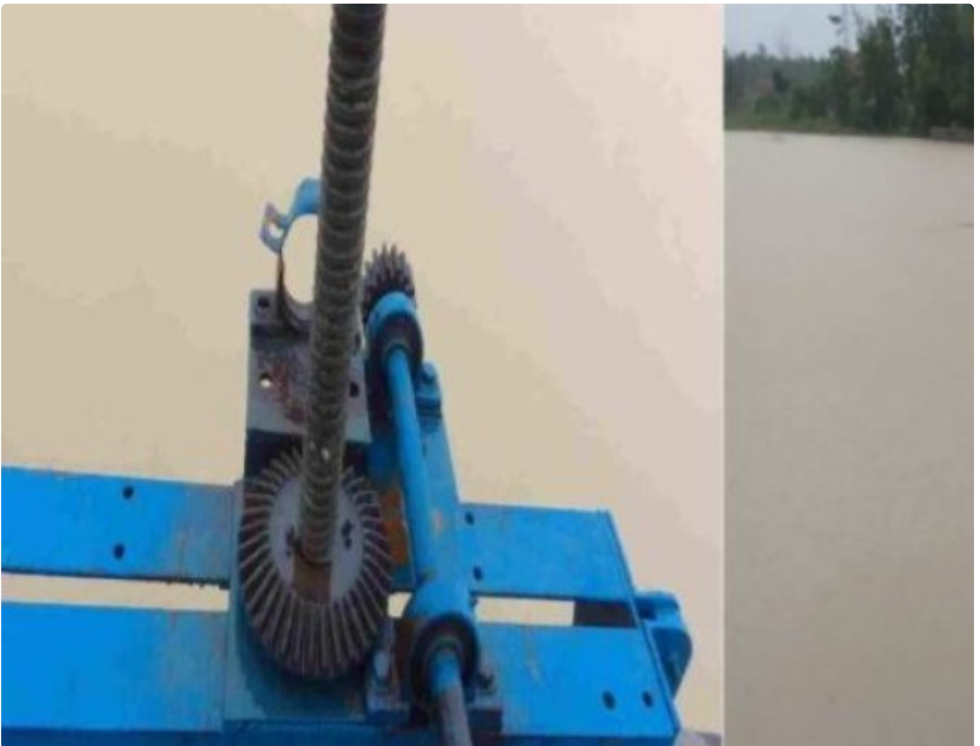
Pintu air Albaret Simpang Mesuji
